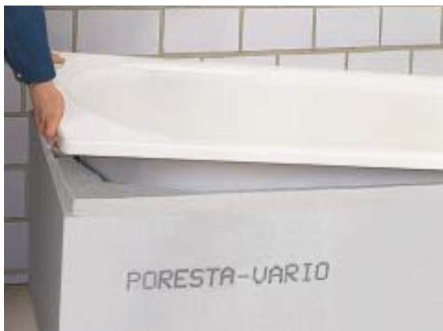
5. Wanne in den Träger einsetzen.
