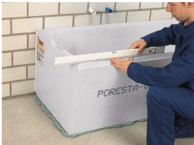
3. Wannenträger setzen und ausrichten.
